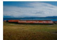
Un galpón para la preparación del pescado, en Puerto Natales, a unas 200 millas al noroeste de Punta Arenas.
